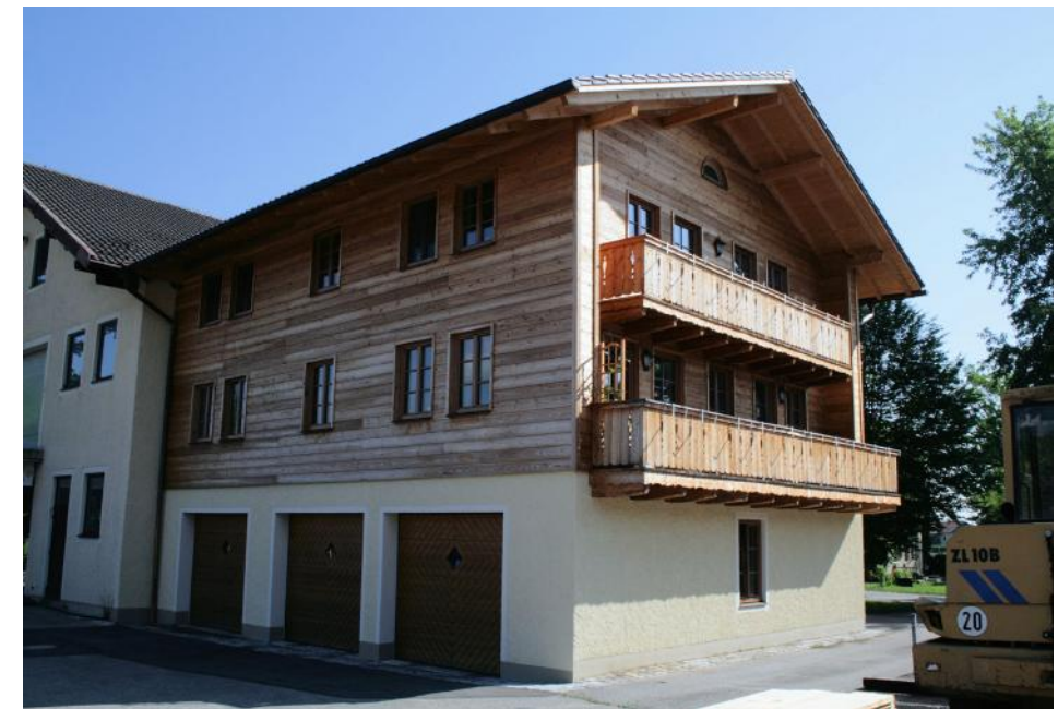
... UND NACH DER BAUMASSNAHME
