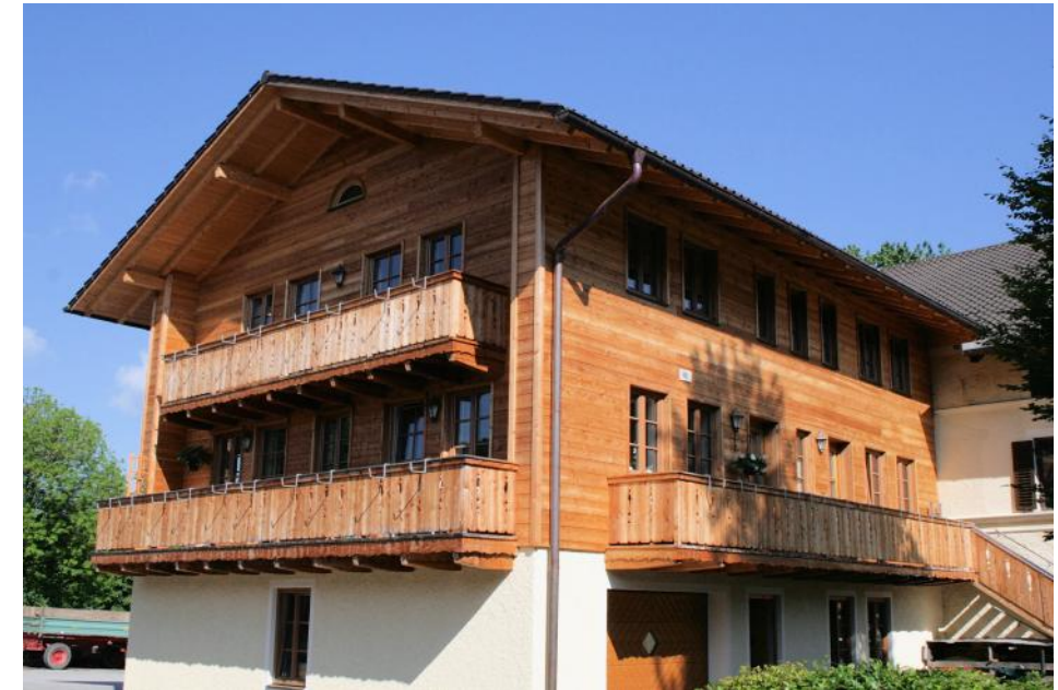
... UND NACH DER BAUMASSNAHME
